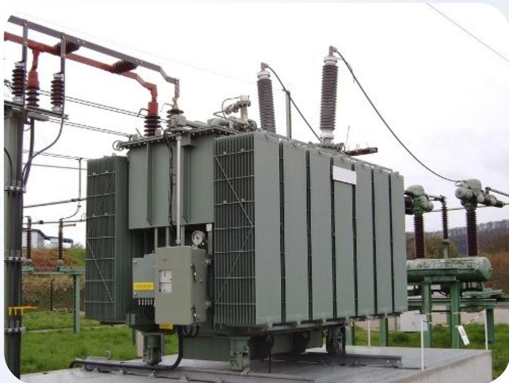
Поэтому и нужны какие-то способы подстройки, регулирования, корректировки сетевого напряжения. Один из лучших способов — это изменение по мере надобности коэффициента трансформации путем уменьшения или увеличения числа витков в первичной или во вторичной обмотке трансформатора, в соответствии с известной формулой:  $U_1/U_2 = N_1/N_2$ .
