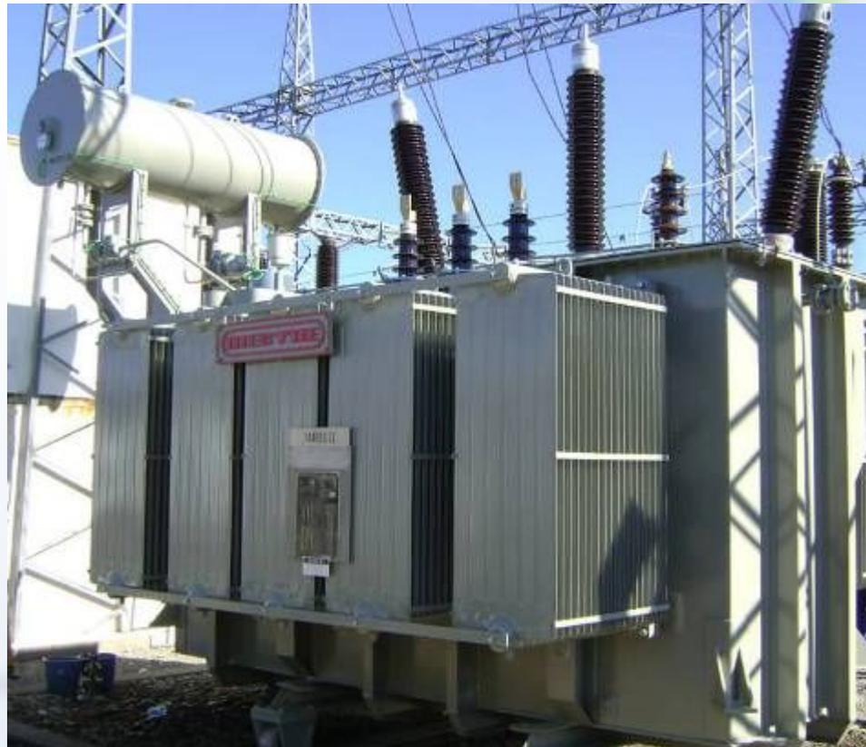
1. Внешняя характеристика трансформатора снимается при постоянном напряжении питания, когда с изменением нагрузки, по сути - с изменением тока нагрузки, изменяется и напряжение на выводах вторичной обмотки, т. е. вторичное напряжение трансформатора.
