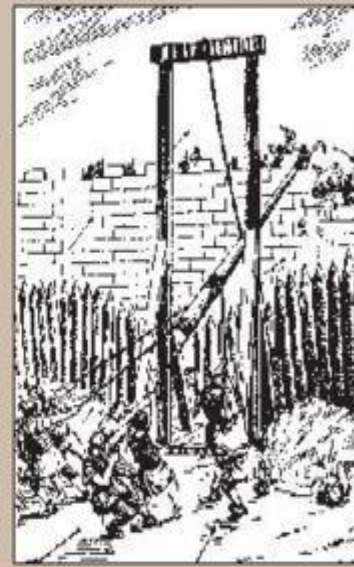
Ворон – разрушитель стен
