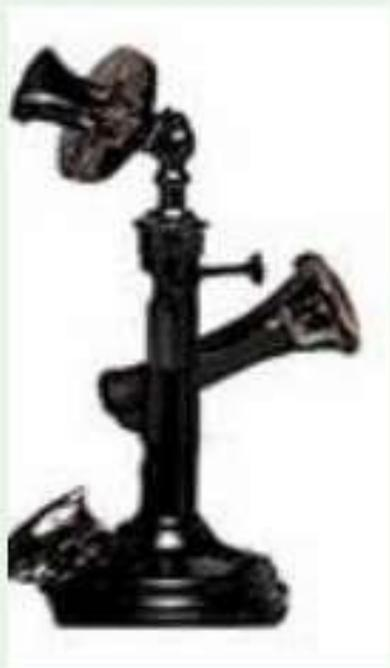
Трубка Белла служила по очереди и для передачи, и для приёма человеческой речи. В телефоне А. Белла не было звонка. Вызов абонента производился через трубку при помощи свистка.
