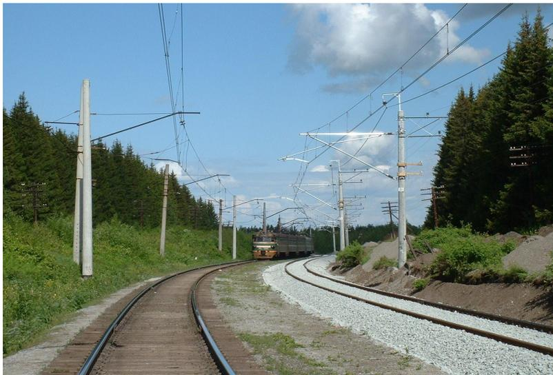
Основной целью создания контактной сети с использованием поддерживающих конструкций из алюминиевых сплавов для российских железных дорог стало обеспечение большей долговечности, надежности, а также технологичности при производстве, монтаже и обслуживании контактной сети железных дорог России для скоростей движения поездов до 160 км/ч.
