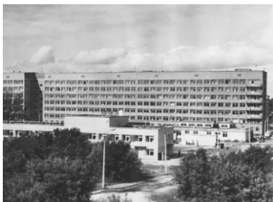
Главный корпус железнодорожной больницы в г. Новосибирске
