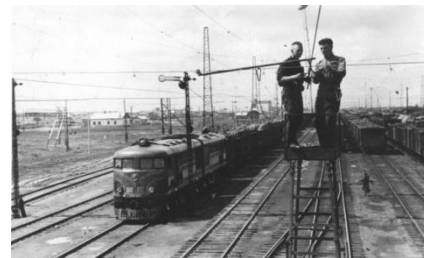
Монтаж контактной сети на Томской железной дороге
