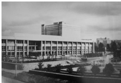
Новое здание Дворца культуры железнодорожников в г. Новосибирске
