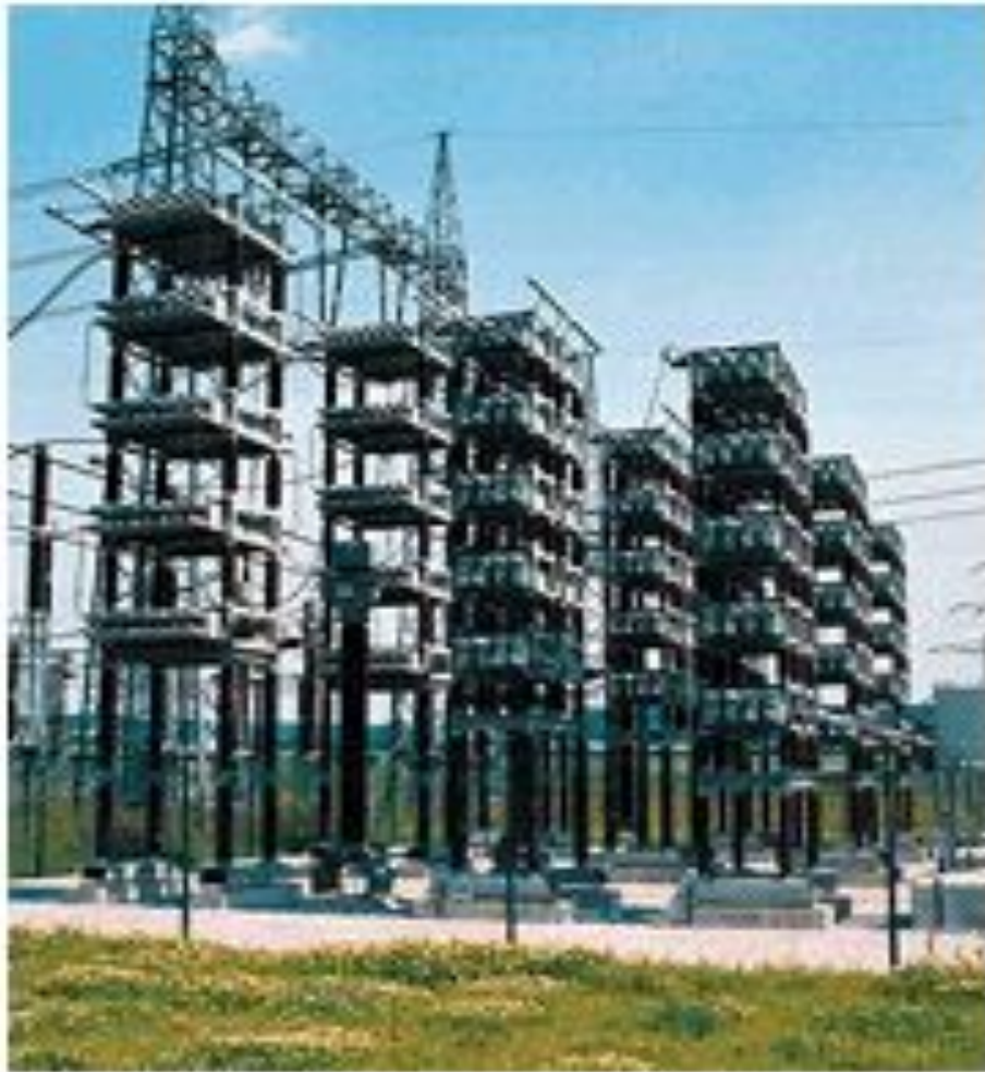
Батарея конденсаторов
