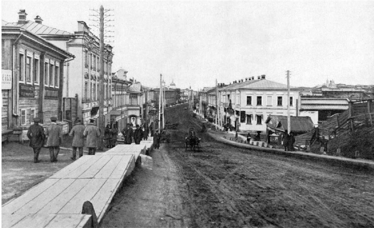
Почтамтская улица 1893 год. Деревянная лестница. Ограждение и освещение отсутствуют.
