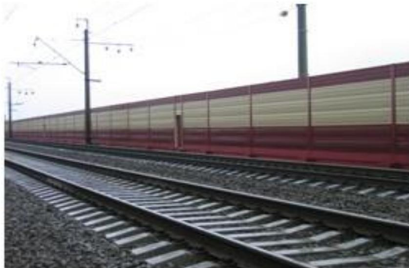
*шумозащитный экран на ст. г.сто Октябрьской железной дороги.(рис) Длина экрана – 600 м, высота – 4,5 м.*
