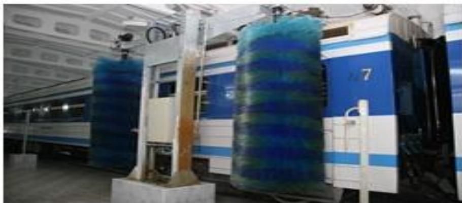
*Комплекс с системой оборотного водоснабжения для мойки электропоездов локомотивного депо Анисовка Приволжской железной дороги*
