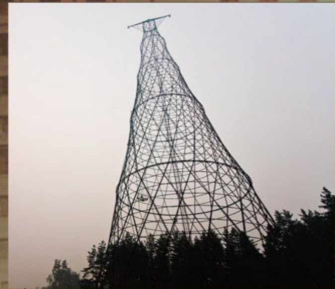
Шуховская башня В. Шухов 1920-1922
