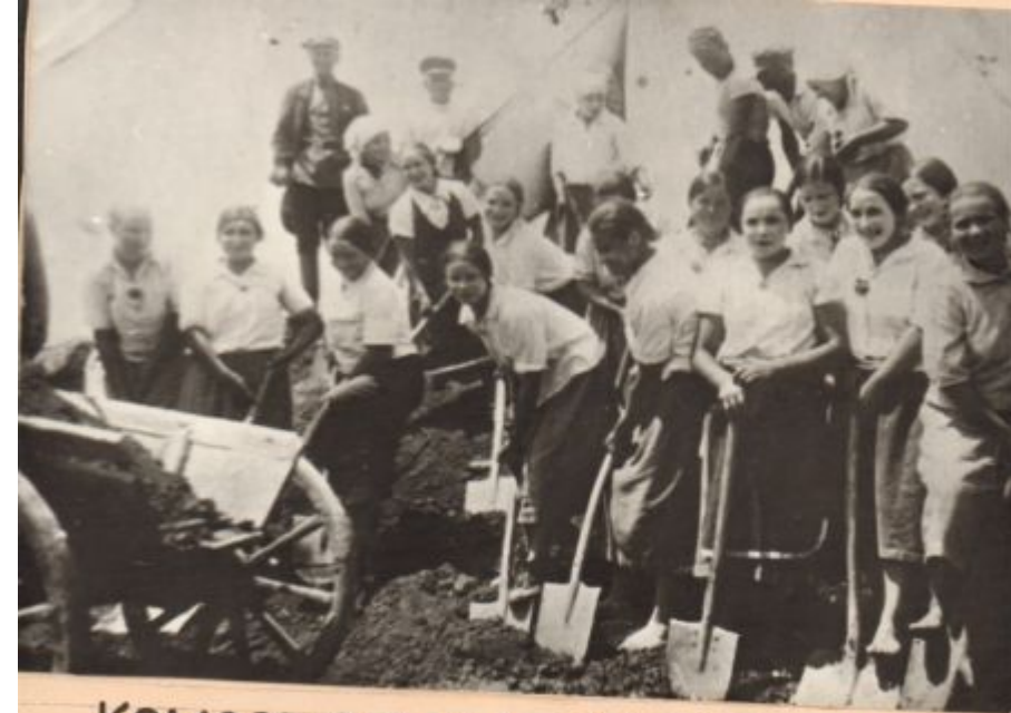
КОМСОМОЛЬЦЫ - СТРОИТЕЛИ ПЛОТИНЫ ЧЕРЕЗ РЕКУ Б.ЕГОРЛЫК
