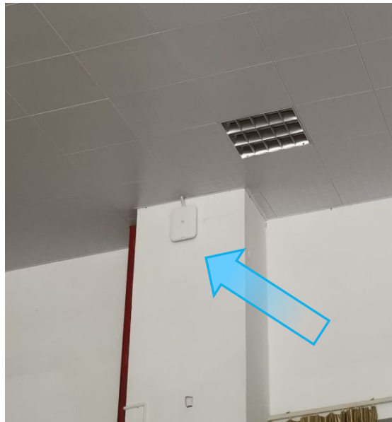
Установка на стене
