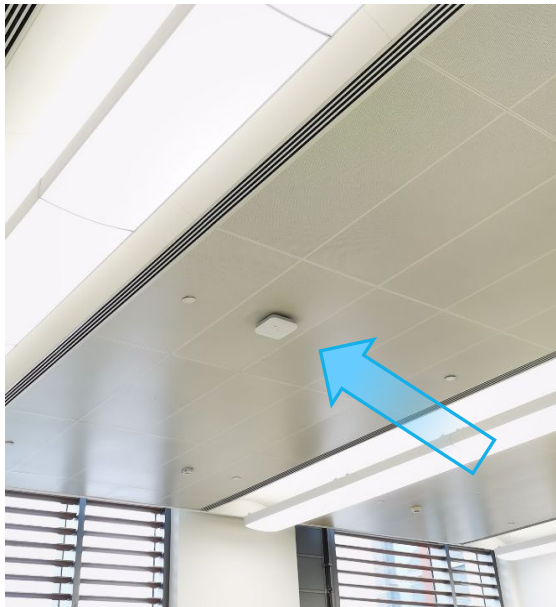
Установка на потолке
