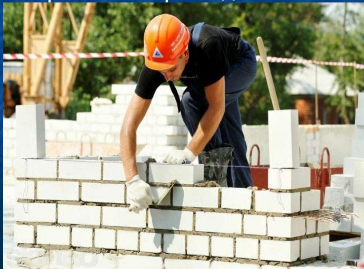
7. Строитель строит дом
