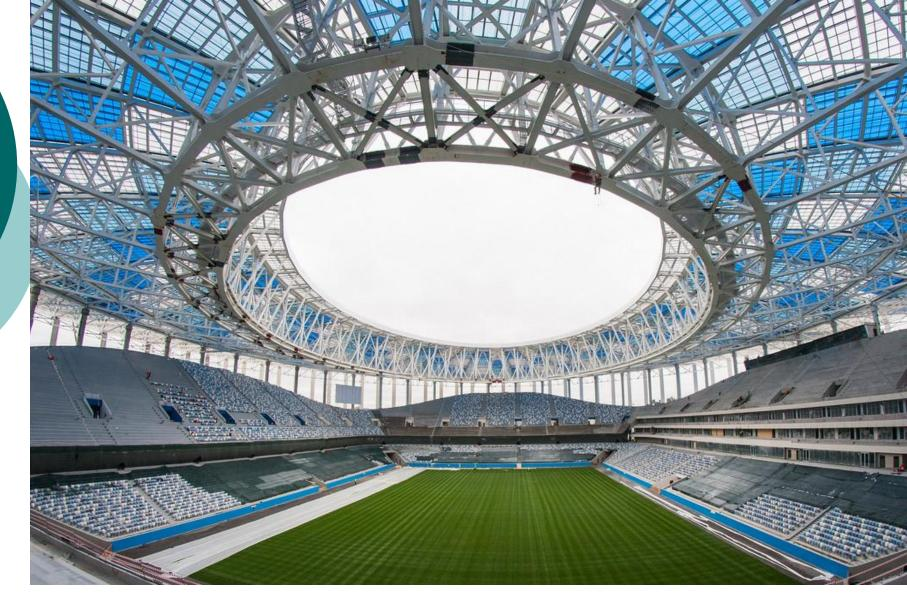
Высота сооружения - 49,5 метров – определена габаритами чаши стадиона и расчетной геометрией конструкций перекрытия.
