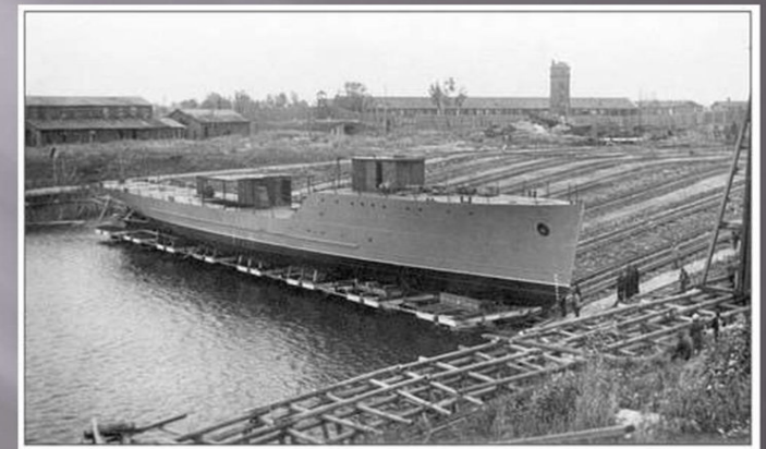
Спуск на воду корпуса тральщика на Средне-Невском судостроительном заводе.
