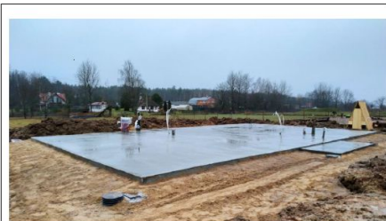
Фото №5 фундамент с коммуникациями
