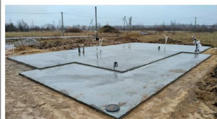
Фото №7 фундамент с коммуникациями
