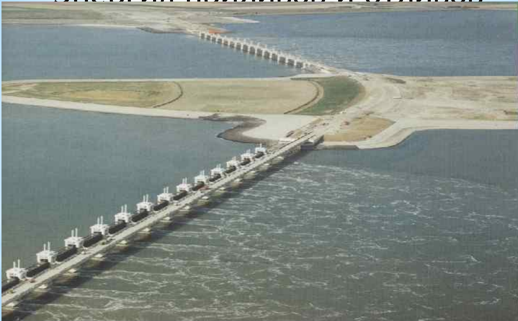
Электростанция (преобразующая энергию приливов и отливов в электрическую)
