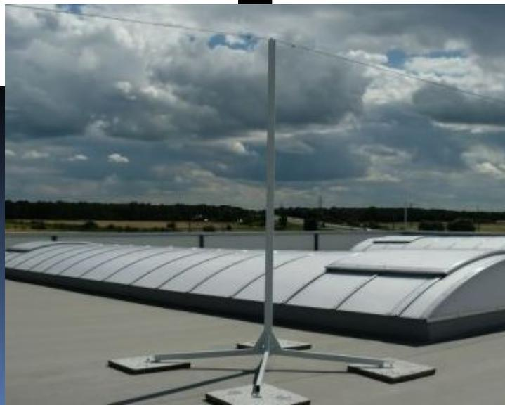
тросовые приёмники, изготавливаемые в виде толстой проволоки, натягиваемой вдоль конька и по периметру кровли
