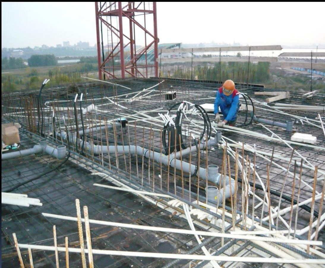
В качестве трубной разводки использовались все комплектующие шведской фирмы Ensto и финской Onienen. В монолитную плиту перекрытия закладывалась трубная разводка для эл. освещения квартир, водопровод, канализация, отопление и все слаботочные сети и пожарная сигнализация
