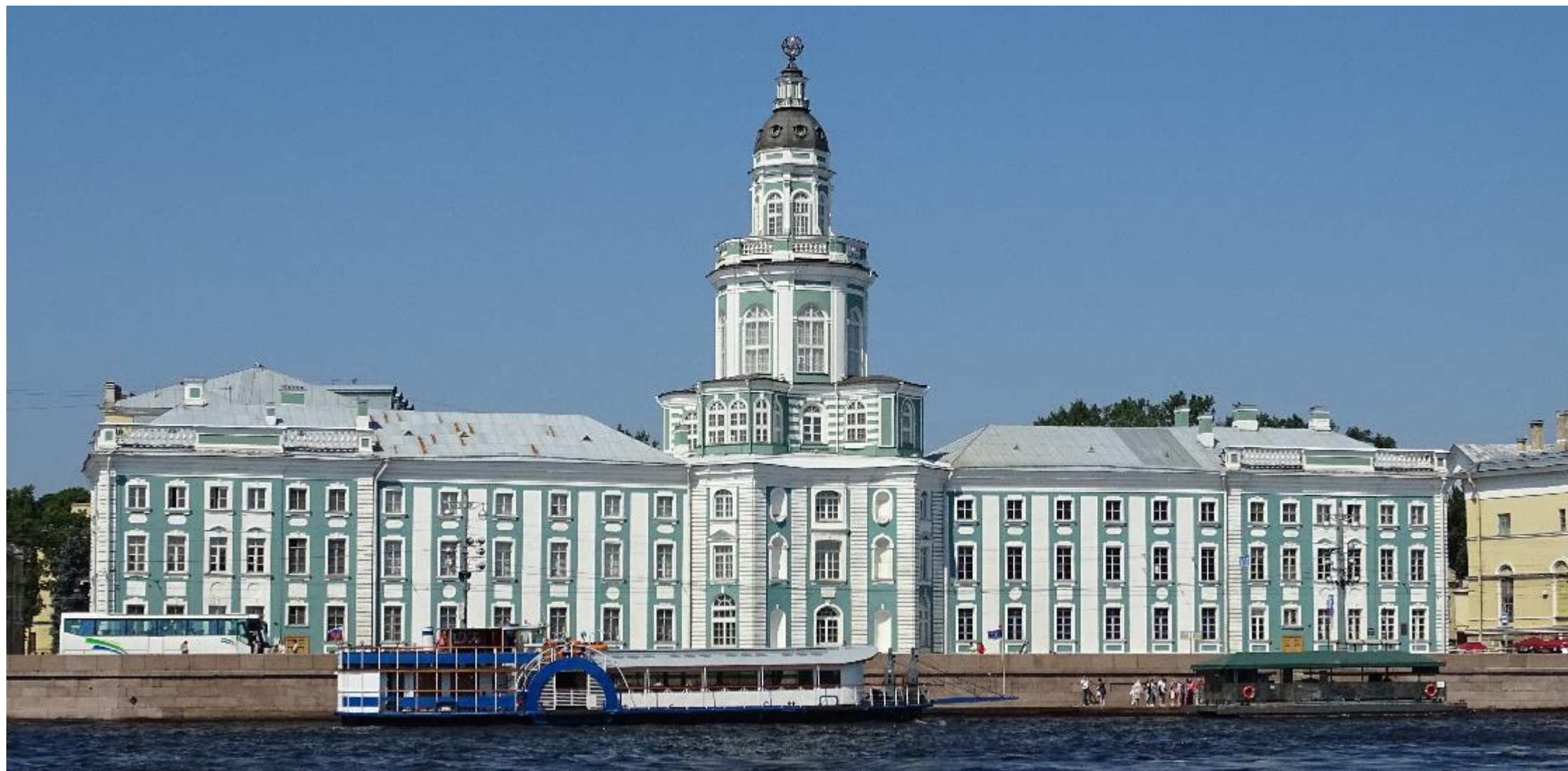
Кунсткамера. 1718 – 1738 гг. Арх. И.С, Маттарнови, Г. Киавери, М.Г. Земцов. Современное фото
