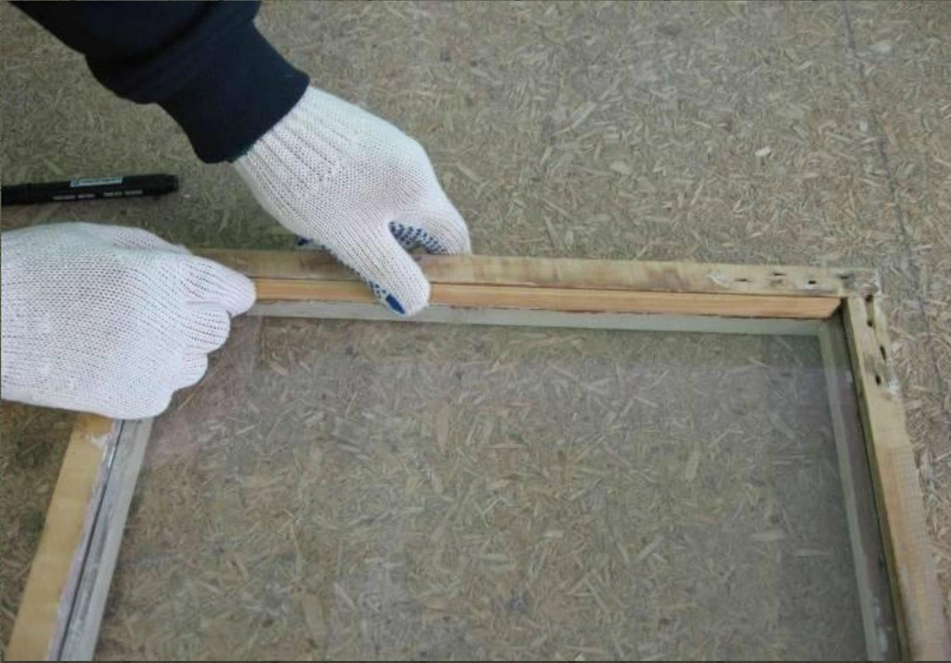
**Вкладываем штапик в фальцы оконной рамы так, чтобы срезы были направлены внутрь.**
