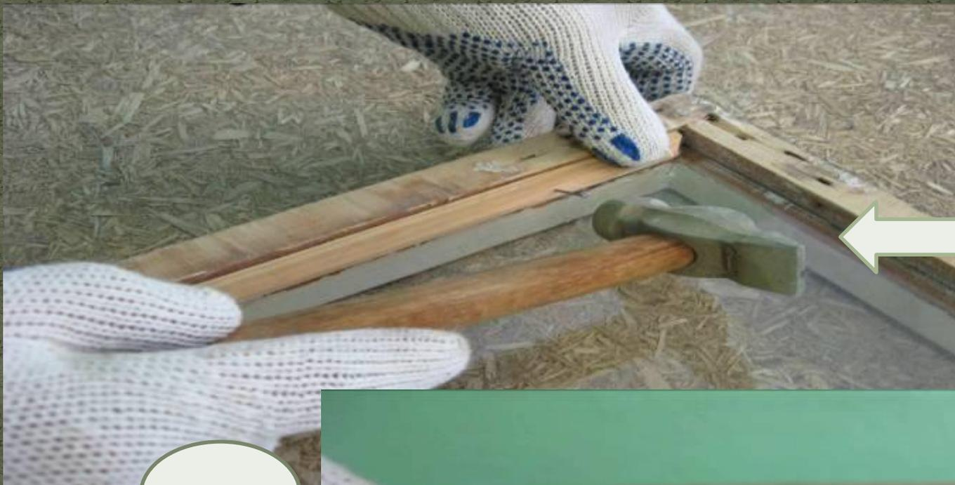
*Придерживая и прижимая штапик, под углом 45 градусов закрепляем его гвоздями. При этом молоток должен «скользить» по стеклу, дабы избежать удара им по полотну*
