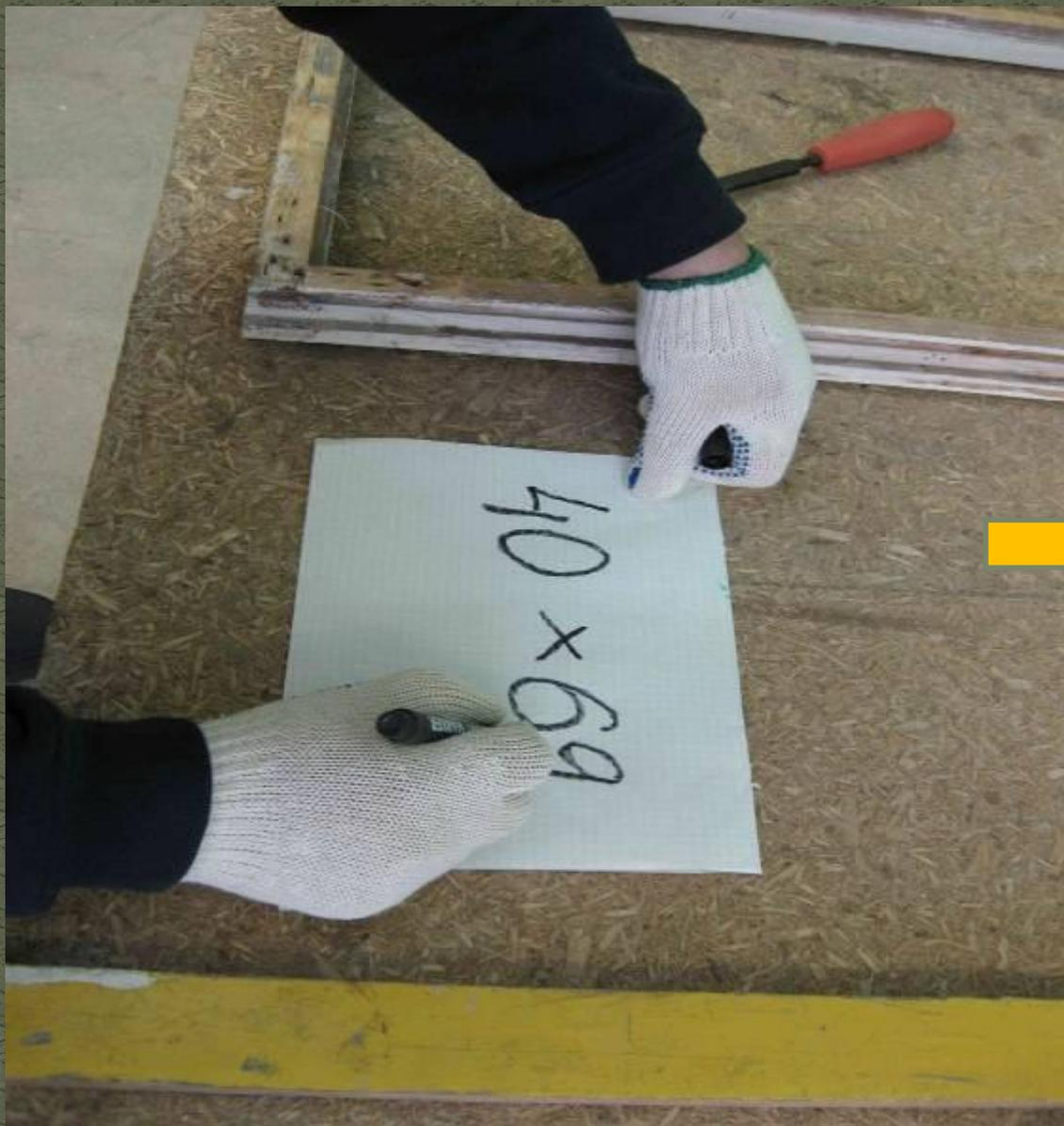
Размеры должны быть меньше на 3-4 мм реальных замеров. Для того, чтобы стекло входило не очень плотно в раму, иначе оно может лопнуть
