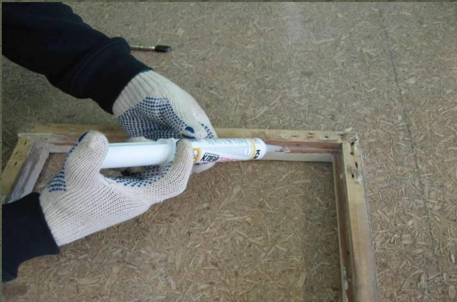
Равномерно выдавливаем клей герметик из тубы, заполняя им фальцы нижней кромки. Герметика не должно быть слишком много или слишком мало: заполнение им пространства должно быть примерно 1 к 6.
