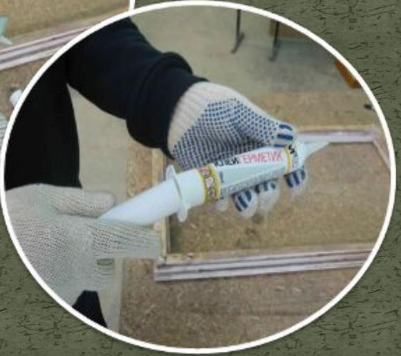
**Готовим герметик для герметизации на фальцы нижней кромки оконного переплета. Он обеспечит более плотное прилегание стекла, перекрыв собою впадины и бугорки.**
