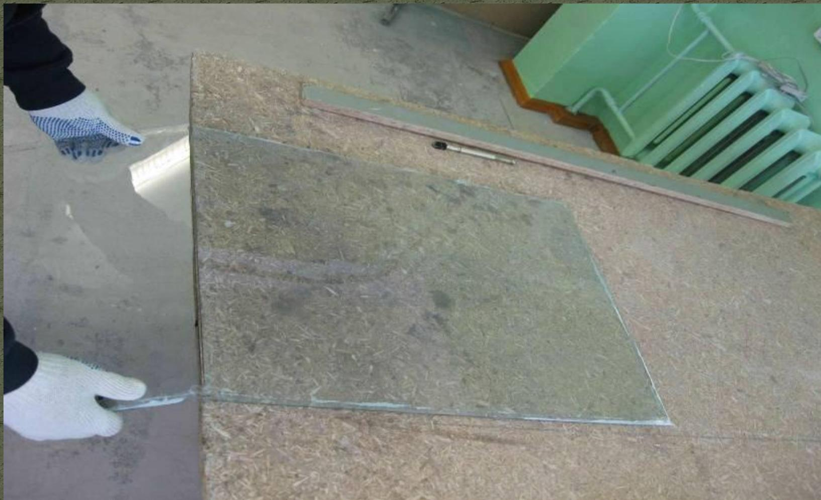
**Резким движением вниз разламываем стекло по линии разреза. Если стекло большого размера, то следует прибегнуть к помощи других. При этом поверх стекла по линии отреза надо положить рейку и легко придавить ею стекольное полотно.**
