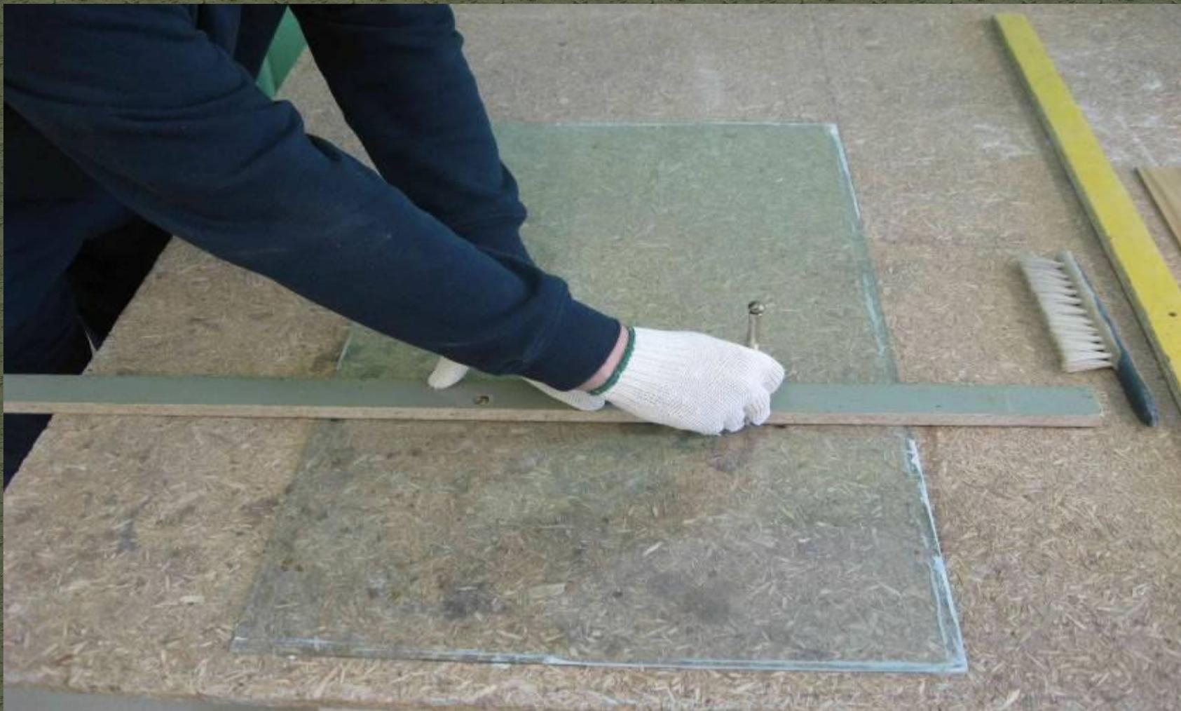
По рейке проводим стеклорезом линию. При этом стеклорез не должен отрываться от стекольного полотна и прорез должен быть равномерным. Для достижения этого нажим на стеклорез должен быть равносильным, чтобы был слышен легкий треск.
