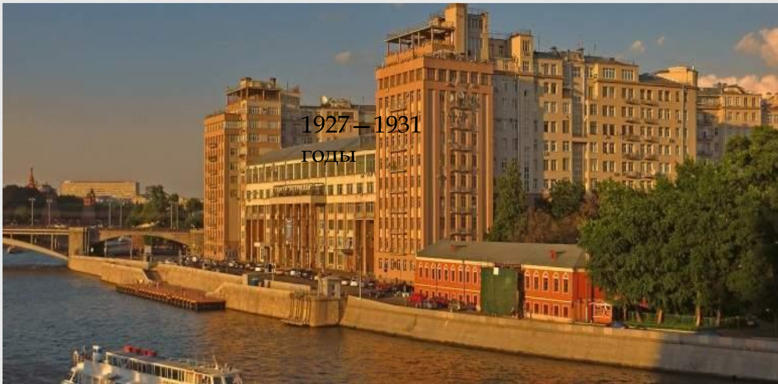
Дом на набережной. (1927-1931 гг). Архитектор Борис Михайлович Иофан.
