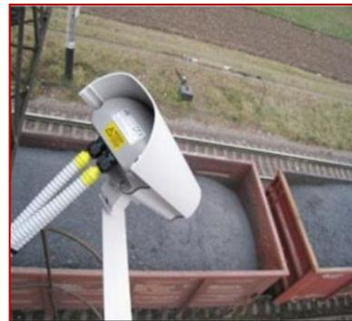
Автоматизированная система коммерческого осмотра поездов и вагонов (АСКО ПВ) - программно-технический комплекс средств автоматизации в составе ПКО движущегося грузового подвижного состава и находящихся на нем грузов и контейнеров с последующим сбором, обработкой, хранением и документированием результирующей информации о коммерческом состоянии вагонов и грузов
