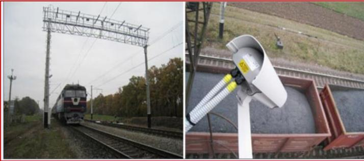
Визуальный контроль состояния вагонов производят с помощью телевизионного изображения. Для этого на несущей конструкции закрепляют телекамеры, направленные на вагон с трех сторон: **справа, слева и две сверху.**
