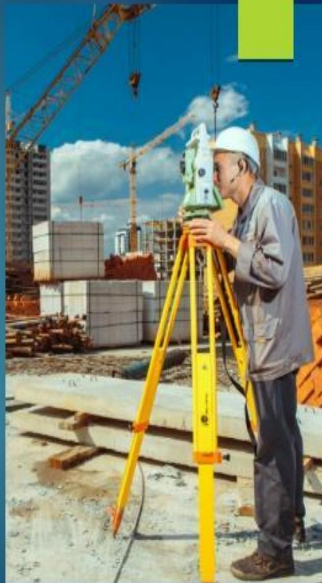
Нельзя оставлять геодезические приборы без присмотра на монтажном горизонте во время перерыва в работе. Геодезические приборы переносят только в упаковочных чехлах, а штативы в сложенном виде. В том случае, если надо перейти с одного места производства работ на другое, теодолит необходимо снять со штатива и переносить в руке.
