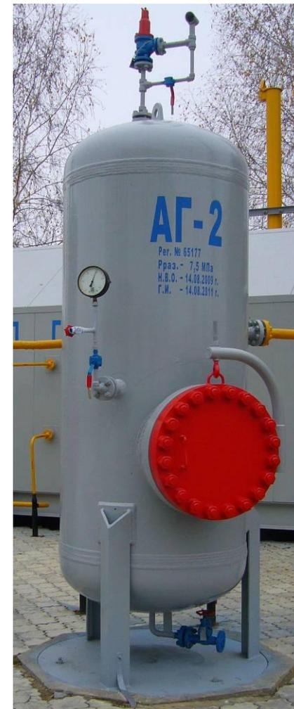
**Баллон** - сосуд, имеющий одну или две горловины для установки вентиля, фланцев или штуцеров, предназначенный для транспортировки, хранения и использования сжатых, сжиженных или растворенных под давлением газов.
