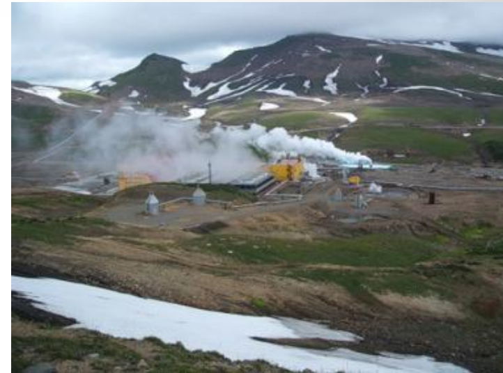
Мутновская геотермальная станция
