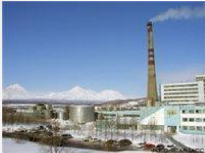
Паужетская геотермальная станция
