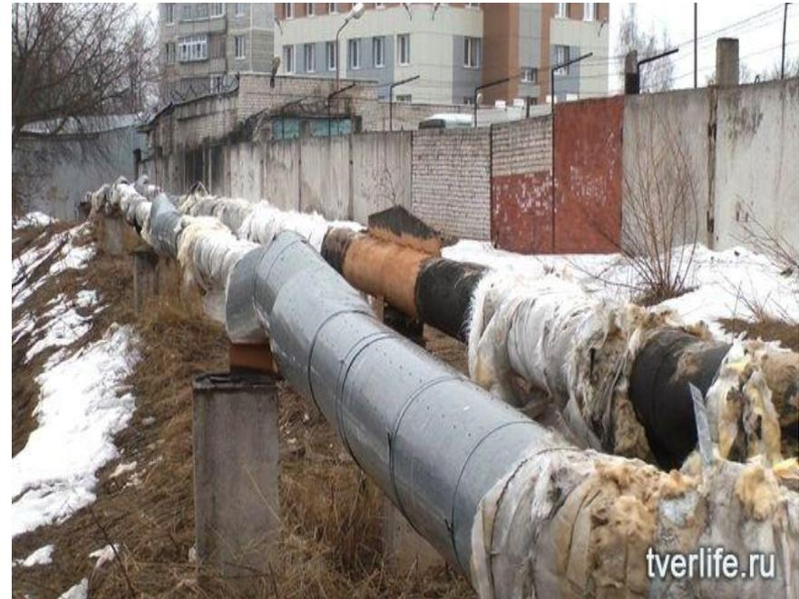
Рисунок 2 – Пример трубы с поврежденной теплоизоляцией
