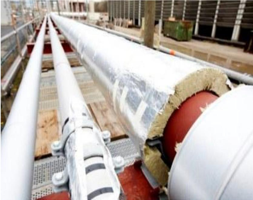
Рисунок 1 – Пример трубы с исправной теплоизоляцией
