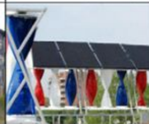
Комбинированная установка ветряков и солнечных батарей
