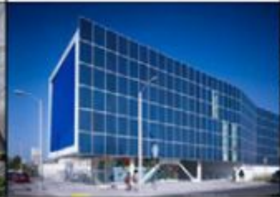
Солнечные батареи, целиком покрывающие фасад здания
