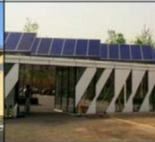
Солнечные батареи на крыше станции зарядки электромобилей
