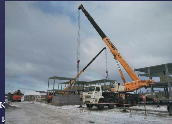
К саморазгружающимся транспортным средствам кроме автосамосвалов относятся цементовозы и саморазгружающиеся автомобили, которые имеют крановое оборудование для разгрузки и погрузки штучных строительных грузов.
