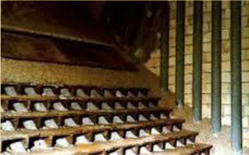
Наклонная неподвижная колосниковая решетка
