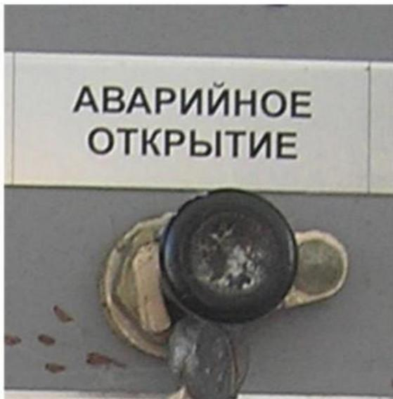
Кнопка «Аварийное открытие» шлагбаумов - двухпозиционная, без фиксации, пломбируемая. Нажимается для открытия шлагбаумов в случае неисправности автоматической цепи извещения о приближении поезда, когда есть необходимость освобождения переезда автогужевым транспортом. (Например: Если при нажатии кнопки «Открытие» полуавтоматические шлагбаумы не переводятся в открытое положение, а автоматические шлагбаумы не переводятся в открытое положение, автоматически).
