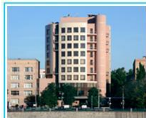
Новое здание Роспатента на Бережковской наб., 24, стр.12
