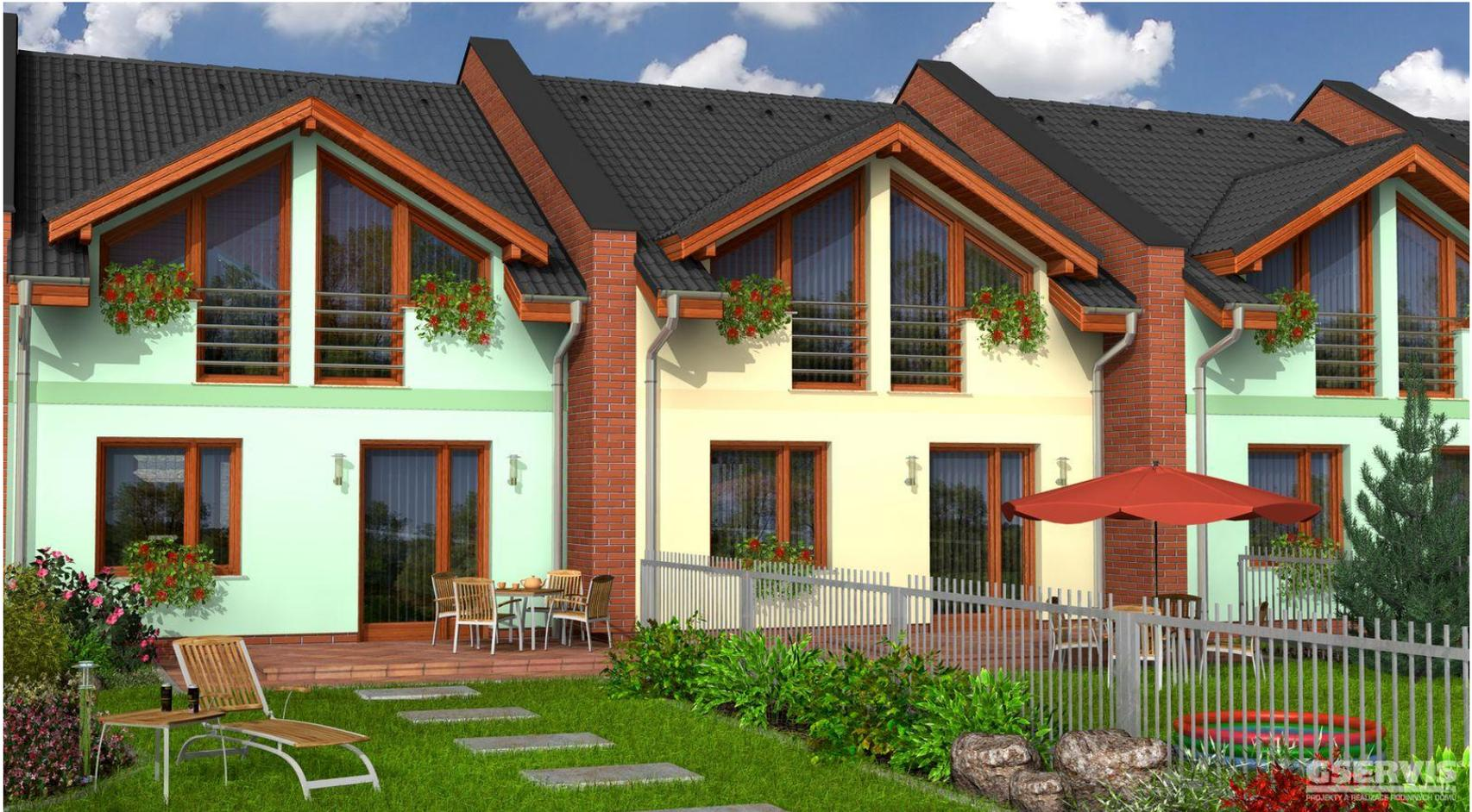
Основная структурная и формообразующая единица дома блокированного типа – блок, представляющий собой законченный объёмно-планировочный элемент, как в строительном, так и инженерном отношении. Жилые дома образуются соединением одинаковых или разных по типам квартир и этажности блоков.
