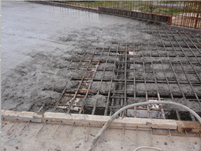
II.3. Улаштування перекриття кутових ділянок при будівництві стадіону Арена-Львів. Об'єм вставок та економія бетону 32%.
