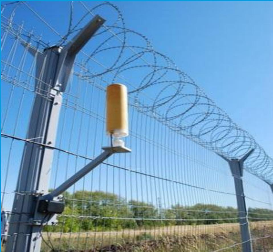
**Инфракрасные линейные извещатели** — предназначены для защиты прямолинейных участков периметра, состоят из двух блоков (двухпозиционные) излучателя, формирующего направленный поток инфракрасного излучения, и блока фотоприемника, принимающего это излучение.
