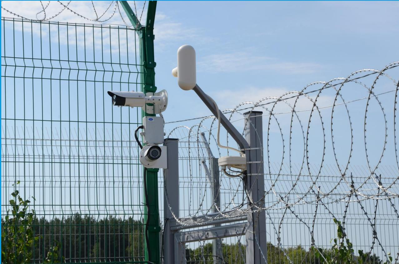
Радиолучевые извещатели - создают объемную зону обнаружения между передатчиком и приемником, расположенными на определенном расстоянии друг от друга. По форме зона обнаружения выглядит, как вытянутый эллипсоид вращения с диаметром от 70 до 600 см. (зависит от антенн и частоты излучения).
