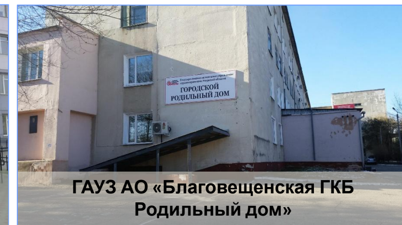
ГАУЗ АО «Благовещенская ГКБ Хирургический корпус»
