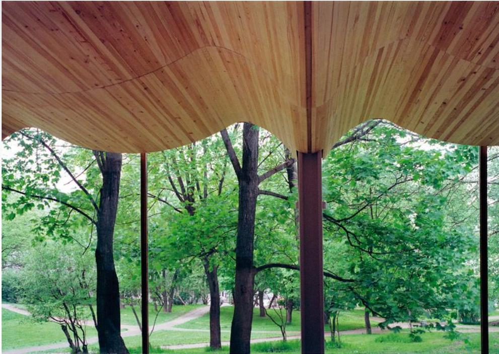
В лекционном зале Аалто построил волнистый потолок из дерева, достигнув при этом замечательного акустического эффекта – в довольно большом зале говорящего слышно с любого места без усилителей звука и микрофонов. Вскоре после войны потолок ухнул, но его получилось воссоздать по оригинальным чертежам.
