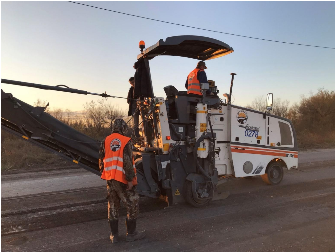
Фрезерование под укладку г. Благовещенск
