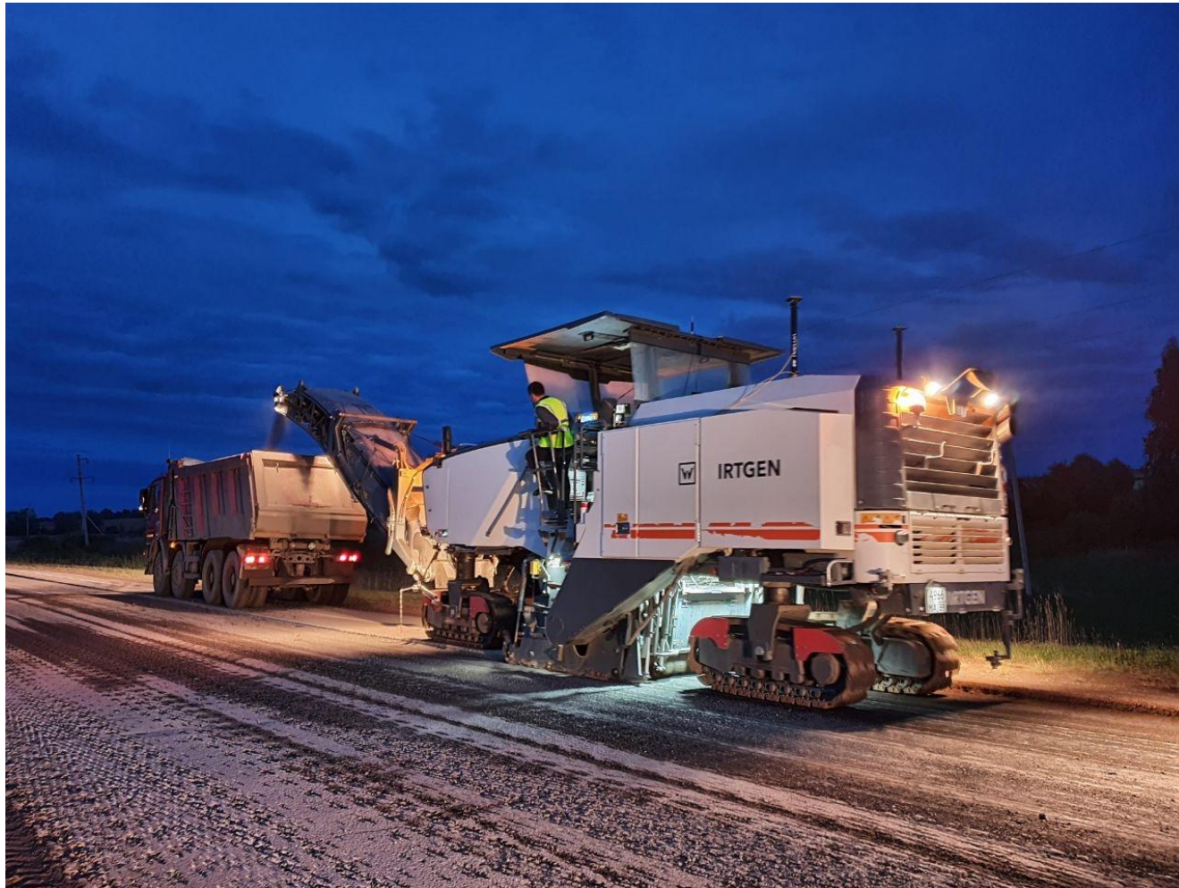
Фрезерование с системой RD-МС г. Уфа
