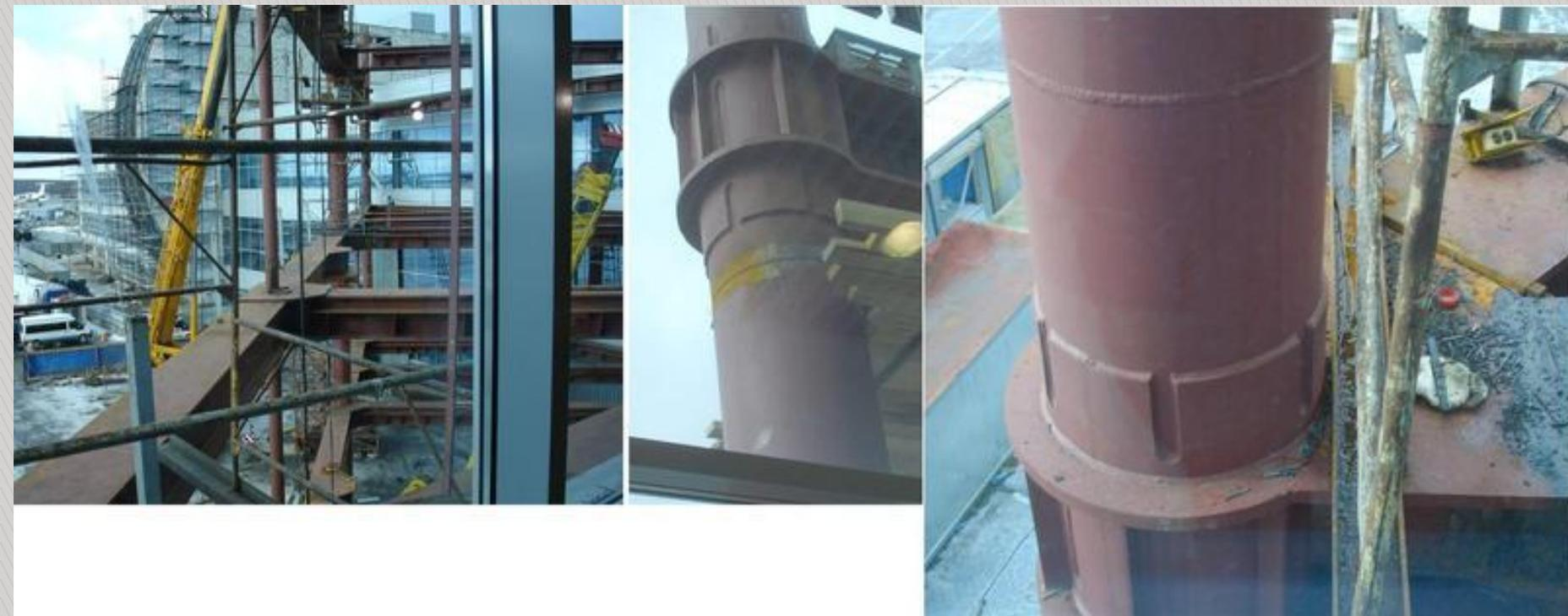
Узел примыкания балки
