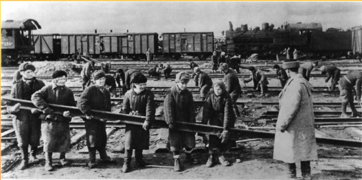
**Замена рельсов на советской железнодорожной станции. На заднем плане виден состав из товарных вагонов, приспособленных для перевозки людей («теплушки») и паровоз серии «Э».**
