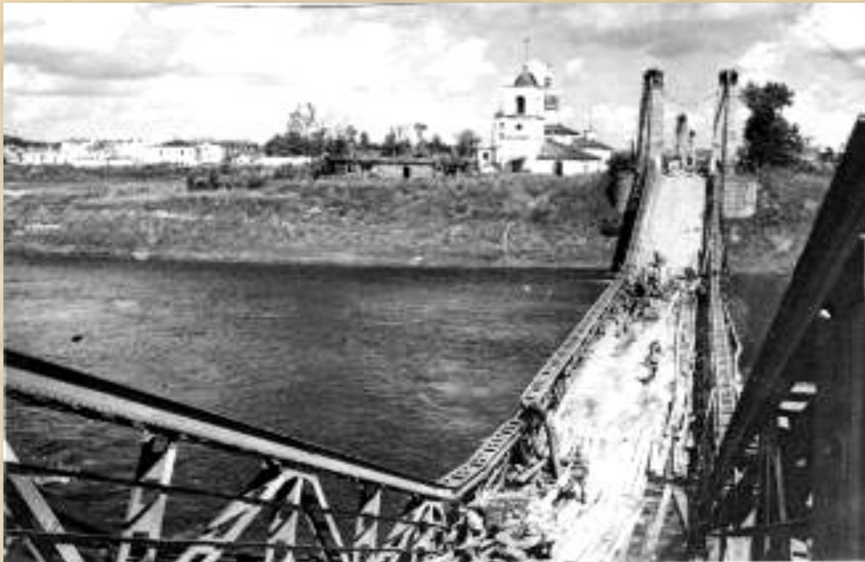
21 июля 1944 г. Взорванный фашистами южный пролет островских мостов
