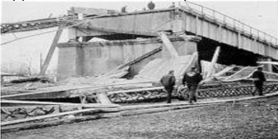
Обрушение Серебряного моста
