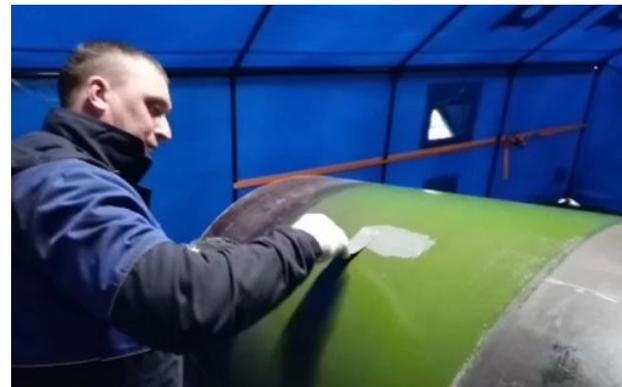
Проведение процесса в один прием, без разрыва между операциями устранения дефекта и последующей изоляции снижает общие временные, материальные и трудовые ресурсы.
