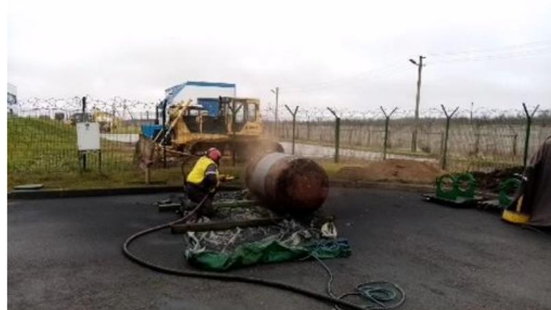
Разработаны новые методики ремонта, позволяющие применять варианты конструкции в зависимости от условий установки и решаемой задачи. Набор применяемых полимерных материалов при этом практически не меняется. Силами УАВРа и ООО «НПП «Биурс» проводятся ресурсные испытания конструкций для подтверждения гарантированного срока эксплуатации не менее 15 лет, что дает право применять разработанные методы ремонта в качестве капитальных.
