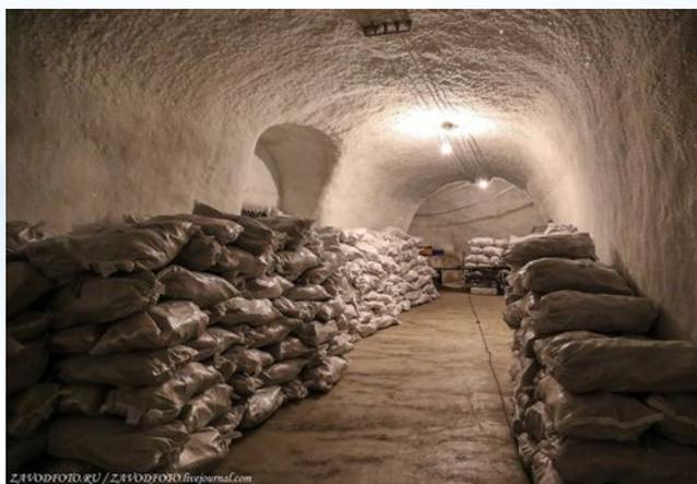
Одновременно мерзлотник «скребут» – удаляется скопившийся за сезон "куржак" и лед, а затем из смеси снега и воды «штукатурят» стены и потолки. Данные работы предотвращают образование запаха в штольнях и ликвидируют скопившийся в виде "куржака" конденсат.
