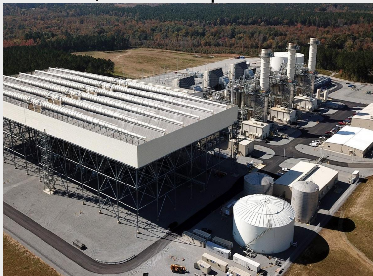
Рисунок 1 Brunswick Country Power Station, Северная Каролина (США)
