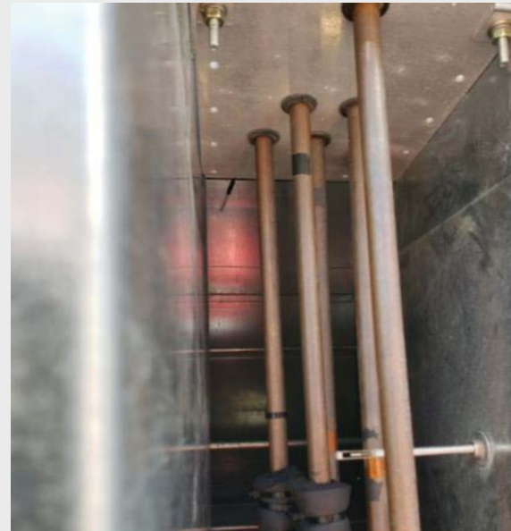
Рисунок 8 Вариант исполнения трубных модулей без оребрения
