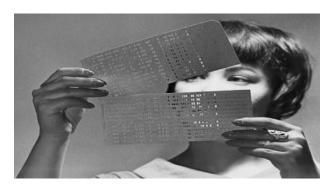
Перфока́рта - носитель информации из тонкого картона, представляет информацию наличием или отсутствием отверстий в определённых позициях карты. Наиболее широко перфокарты применялись во второй половине XX века для ввода и хранения данных в системах автоматизированной обработки информации.
