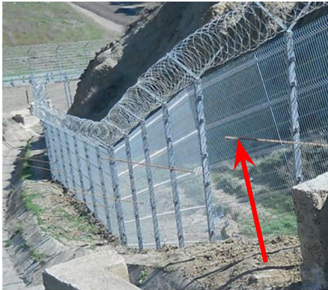
Рис. 4 Проводнoволокнoвой извещатель
