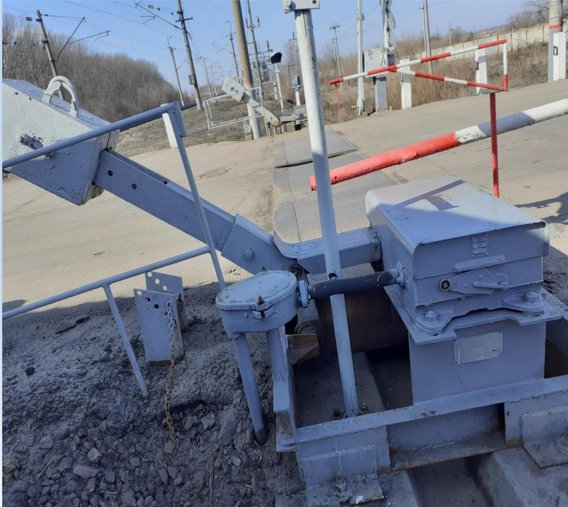
Осмотрел монтаж электропривода. Монтажные провода без скруток и паяк, имеют исправную изоляционную поверхность. Концы проводов заделаны в наконечники и надежно закреплены
