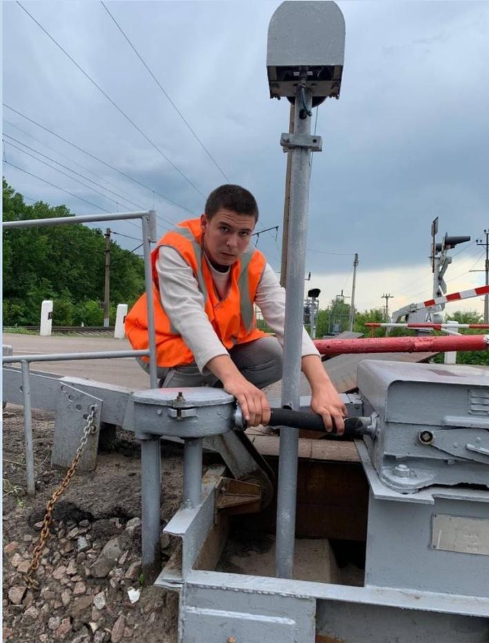
Произвожу внешний осмотр шлагбаума с фундаментом на предмет отсутствия механических повреждений и следов коррозии. Проверяю в месте ввода кабелей в электропривод и под самим электроприводом отсутствие мусора. Проверяю крепление и состояние защитных труб, надежность защиты кабелей, подводимых к электроприводу от механических повреждений.
