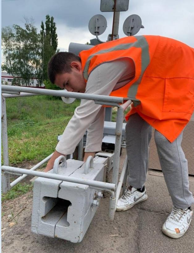
Амортизационное устройство обеспечивает плавность при остановке бруса в крайних положениях и исключает удары о грунт. Заградительный брус соединяется с металлической рамой осью и шариковым фиксирующим устройством.
