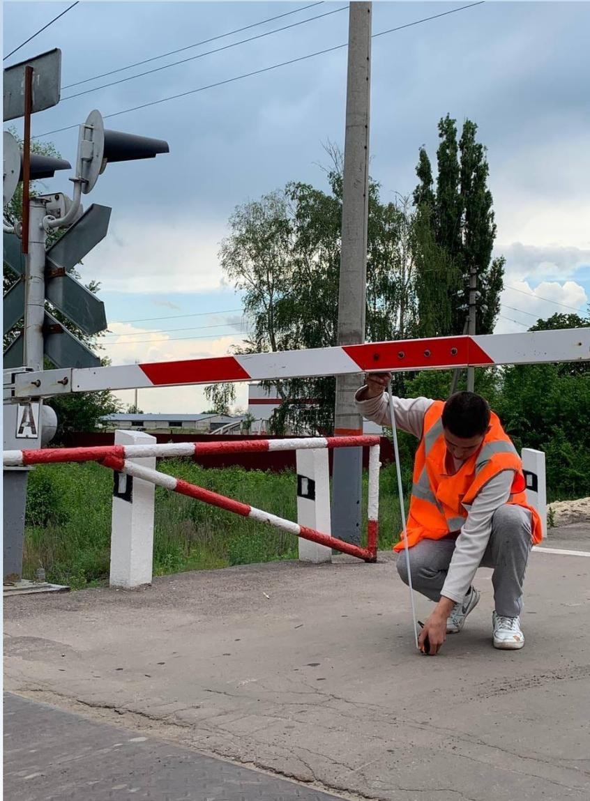
Заградительный брус шлагбаума в горизонтальном положении должен находиться на высоте от 1,0 м до 1,25 м от уровня дорожного покрытия. Положение бруса регулирую с помощью противовесов, а также амортизационным устройством.
