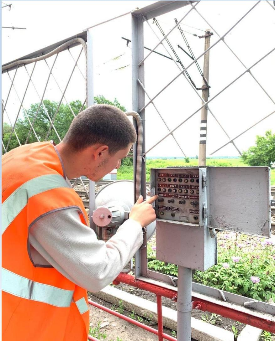
При определении тока выявил, что пружина автопереключателя имеет следы подгара. Это указывает на не плотное прилегание пружины. Удаляю налёт наждачкой и специальным приспособлением подгибаю пружину. Принудительно курбелем перевожу привод в горизонтальное и вертикальное положение и проверяю работу автопереключателя. Напряжение, подаваемое на электродвигатель, измеряю непосредственно на его контактах.
