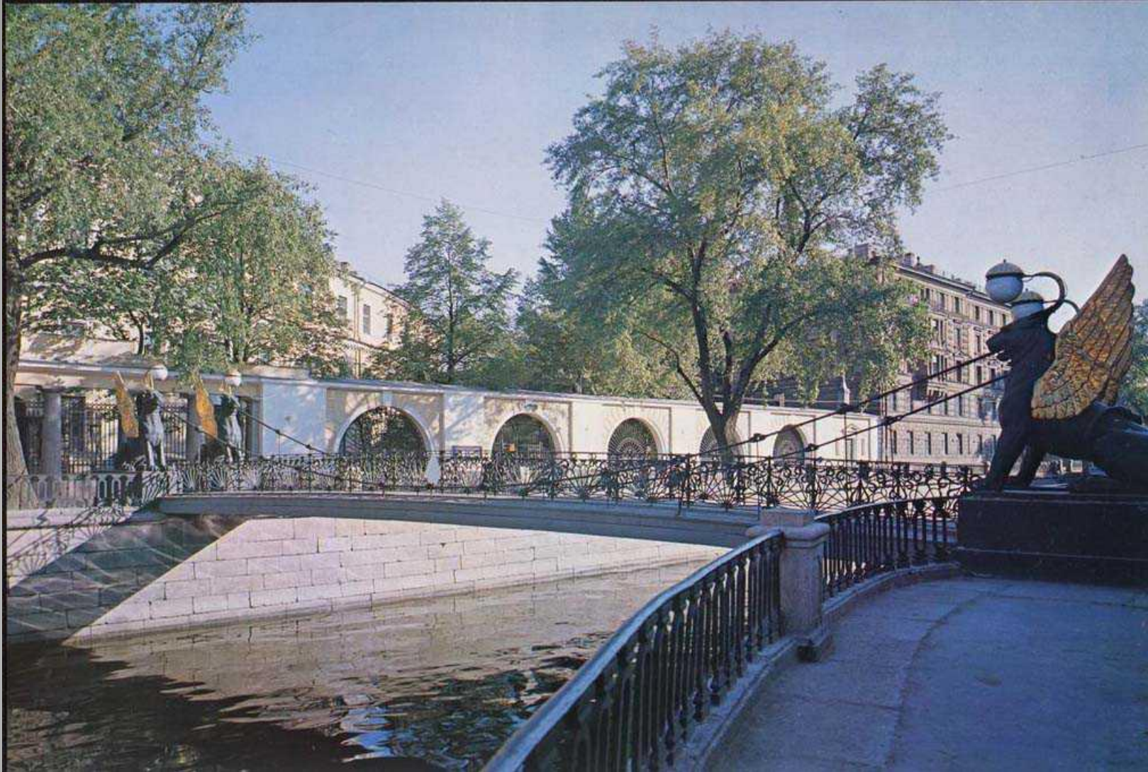
Банковский мостик на канале Грибоедова. 1825 – 1826 гг. Скульптор П.Соколов, инженер Г.Треттер
