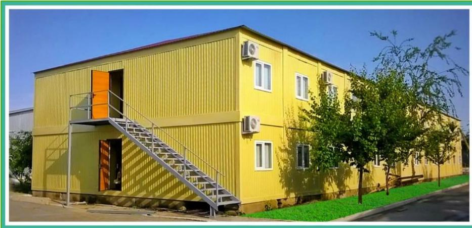
Данное модульное здание предназначено для размещения контрактных сотрудников МВД. Здание спроектировано с учётом размещения в комнатах отдельных санузлов. Каждая жилая комната имеет: водяное отопление, водоснабжение, канализацию, вытяжную вентиляцию
