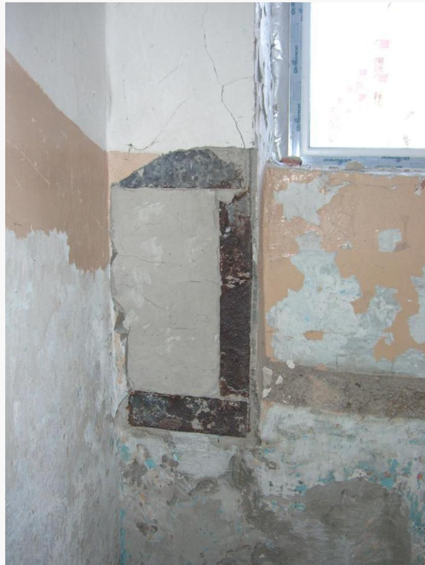
*Выявлены элементы усиления стен в виде стальной обоймы из уголков и пластин. Необходимо выяснить причину*
