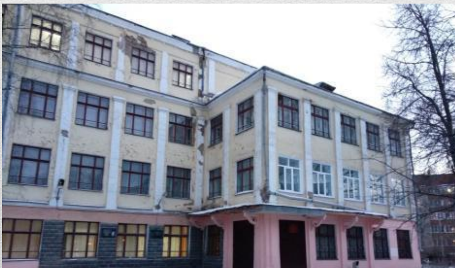
Капитальный ремонт школы №23
