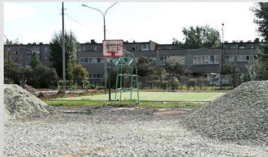
Строительство стадиона школы №13
