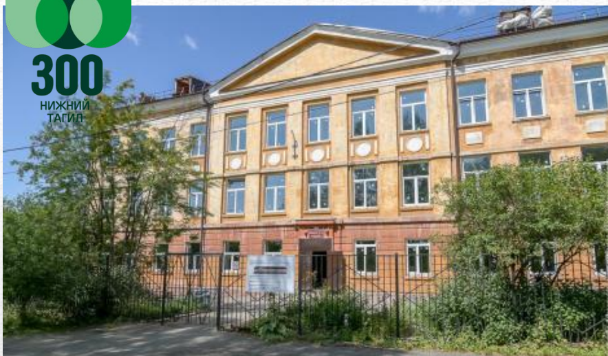
Капитальный ремонт школы №24
