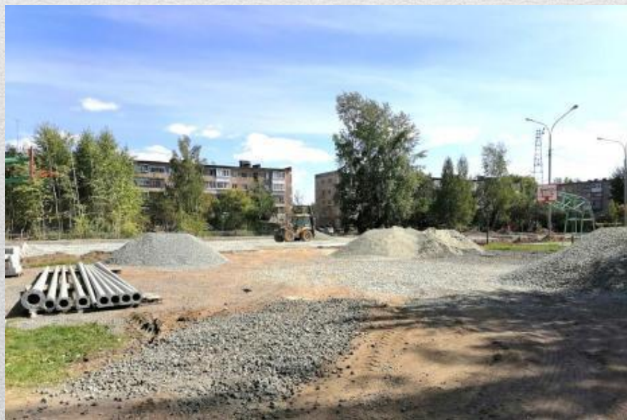
Строительство стадиона школы №9
