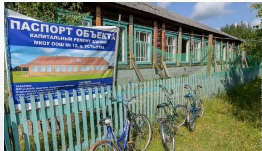
Капитальный ремонт школы №12
